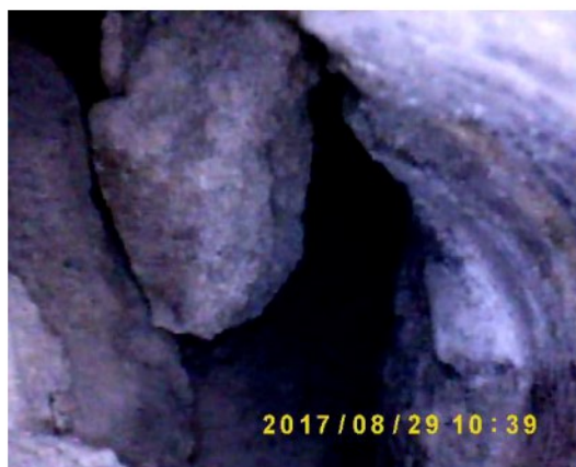
Rys. 35. Przykłady praktyczne występowania niejednorodności struktury wypełnienia złączy (tzw. „raków”) uzyskane z badań istniejących złączy konstrukcyjnych budynków wybudowanych w systemie Wk-70 (widok z kamery inspekcyjnej) [25].
