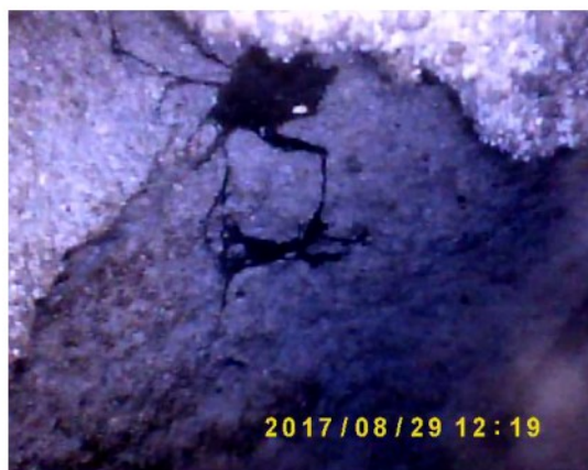
Rys. 35. Przykłady praktyczne występowania niejednorodności struktury wypełnienia złączy (tzw. „raków”) uzyskane z badań istniejących złączy konstrukcyjnych budynków wybudowanych w systemie Wk-70 (widok z kamery inspekcyjnej) [25].
